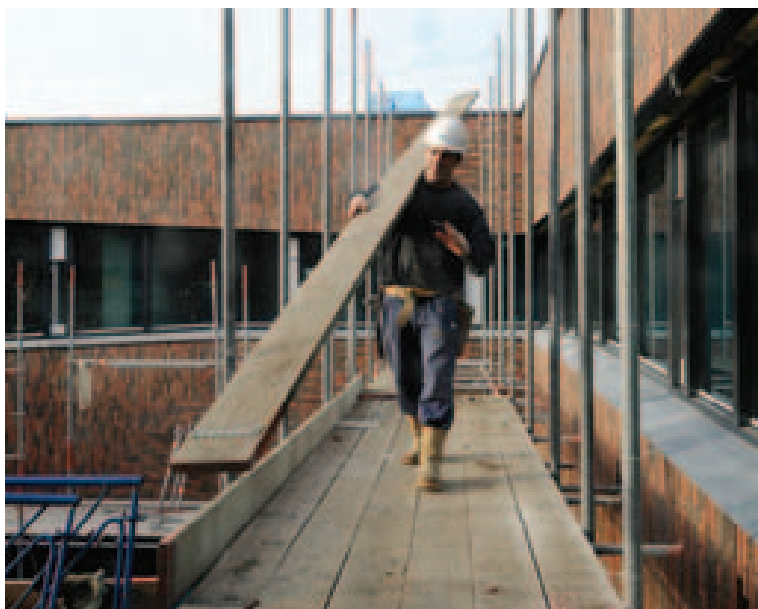
Werk in uitvoering.
